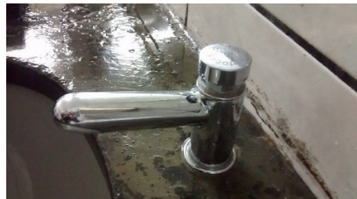
(b) Torneira de funcionamento hidromecânico (T.2)
