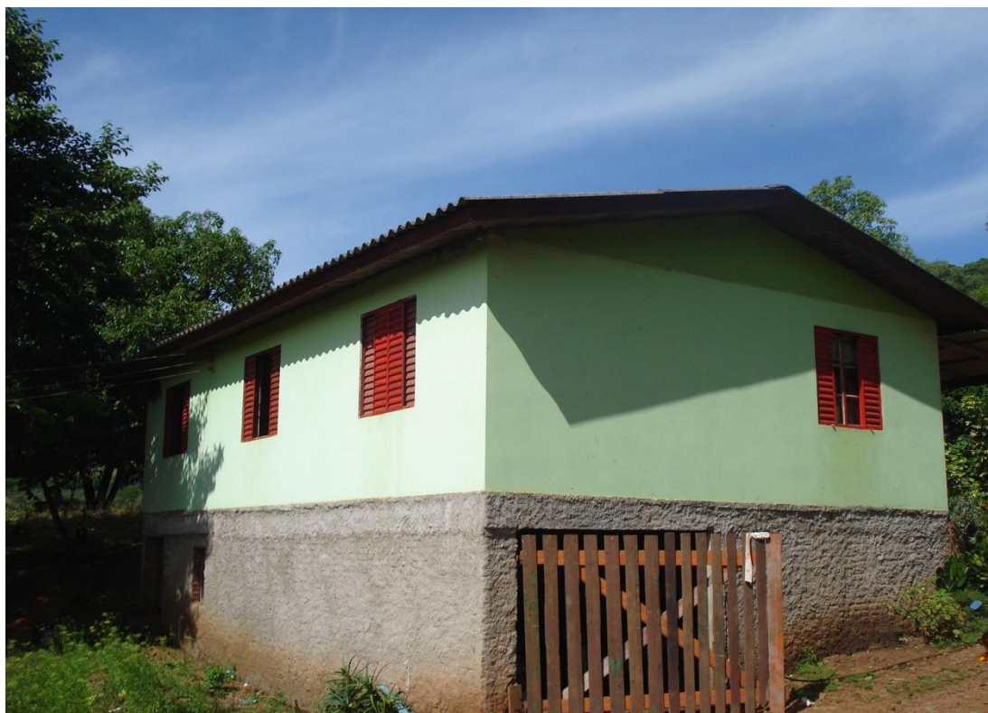
Figura 5. Casa de construção recente. 2011.
