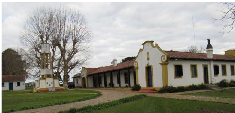
Foto 2.1 Sede da Fazenda do Socorro
