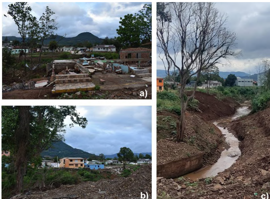
Figura 6: Situação do núcleo urbano de Roca Sales pós-enchente
