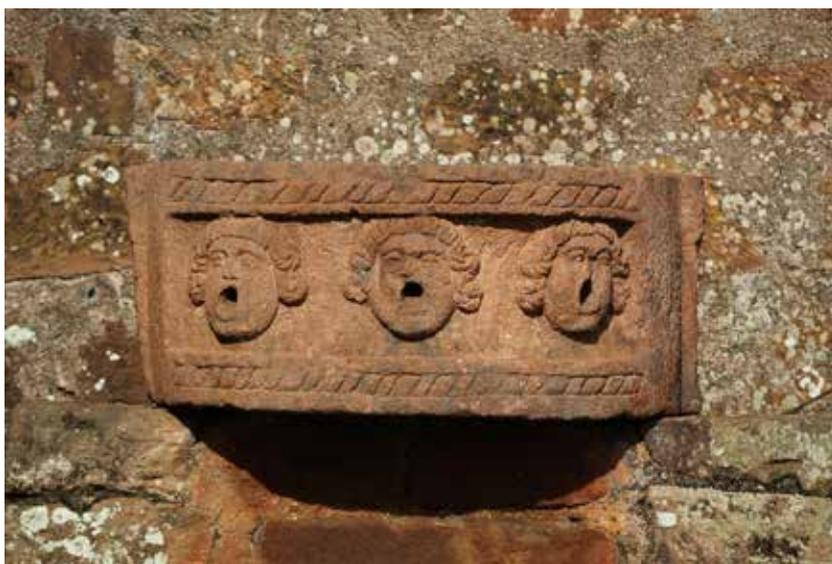
**Figura 2:** Fonte em arenito após o procedimento de conservação, contrastando com a parede ao fundo, a qual não recebeu tratamento.
