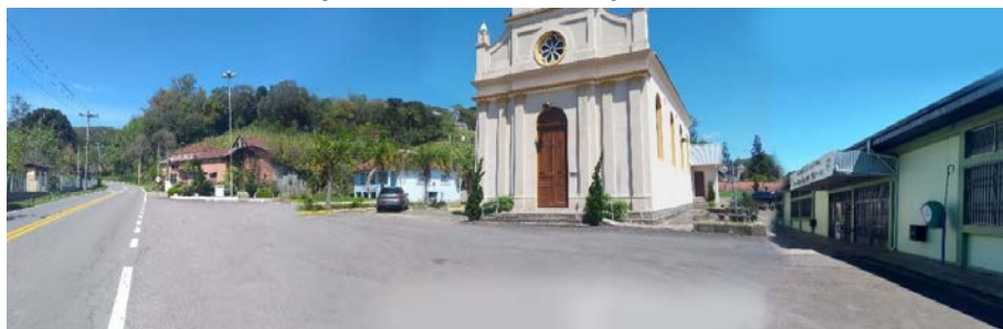
Figura 8 – Foto panorâmica da conexão E8, da Capela Nossa Senhora das Neves, à direita a sede do clube Palmeiras e ao fundo à esquerda uma das edificações históricas do conjunto Adami.
