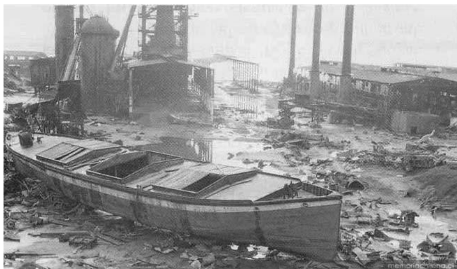
Figura 3 – Barcos e industrias destruidas en Valdivia tras el maremoto de 1960
