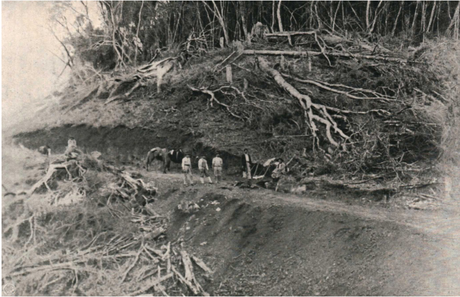
Imagem 4 - Fotografia intitulada “Estrada em construção para as fontes do “Mel” - Trabalhos summarios de terraplenagem para o prompto acesso”, Comissão de Palmeira, 1918.
