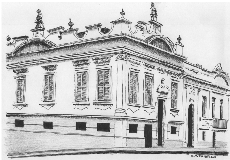
Figura 15: Residência na esquina da Rua Duque de Caxias com a Rua General Auto.
