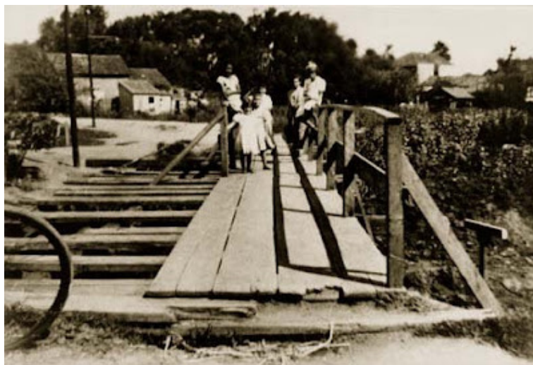
Figura 2 - Ponte sobre o Arroio Dilúvio com a Ilhota ao fundo
