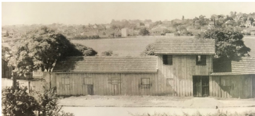
Figura 19 - Cocheiras do Hipódromo dos Moinhos de Vento. Singela construção que abrigava as cocheiras, por onde atualmente passa a Rua Comendador Caminha.
