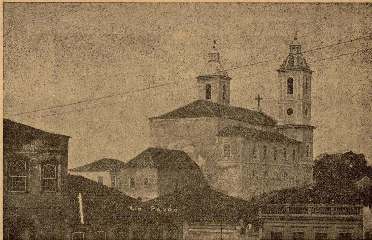
Matriz vista pelos fundos. Os pontos de referencias fornecidos pelas casas que se levantam em seu derredór dão uma nítida idéa da magestade do templo.
