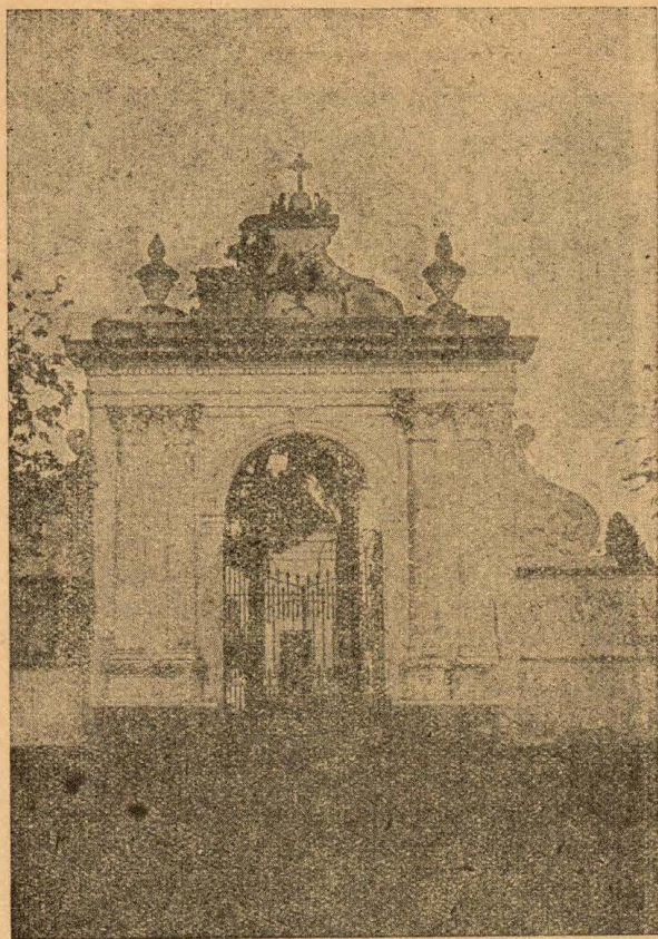
Portão do cemiterio construido em 1860 no ponto mais elevado da cidade. A suavidade de suas formas contrasta com a feiura dos capiteis
