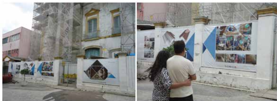
Figura 10: Painéis finalizados e fixados na área de isolamento da obra.
