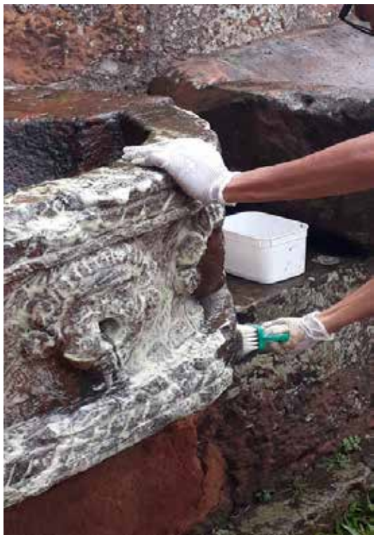
Figura 1: Procedimento de escovação da fonte em arenito, utilizando sal quaternário de amônio à 3%.
