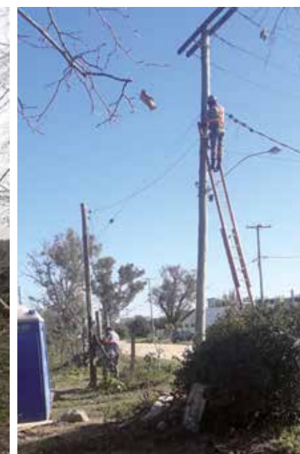
Figura 4: Instalação de poste e rede de energia elétrica para abastecimento da comunidade indígena Yyrembé Fonte: Eduardo Ortiz
