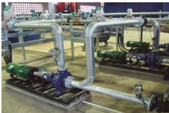
Figura 3: Conjunto motobomba da malha de consumo do LENHS
