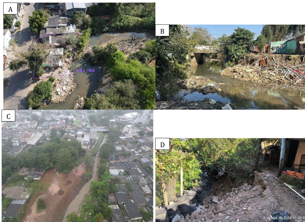
Figura 10 – Situações de risco em pontos específicos dos setores demarcados
