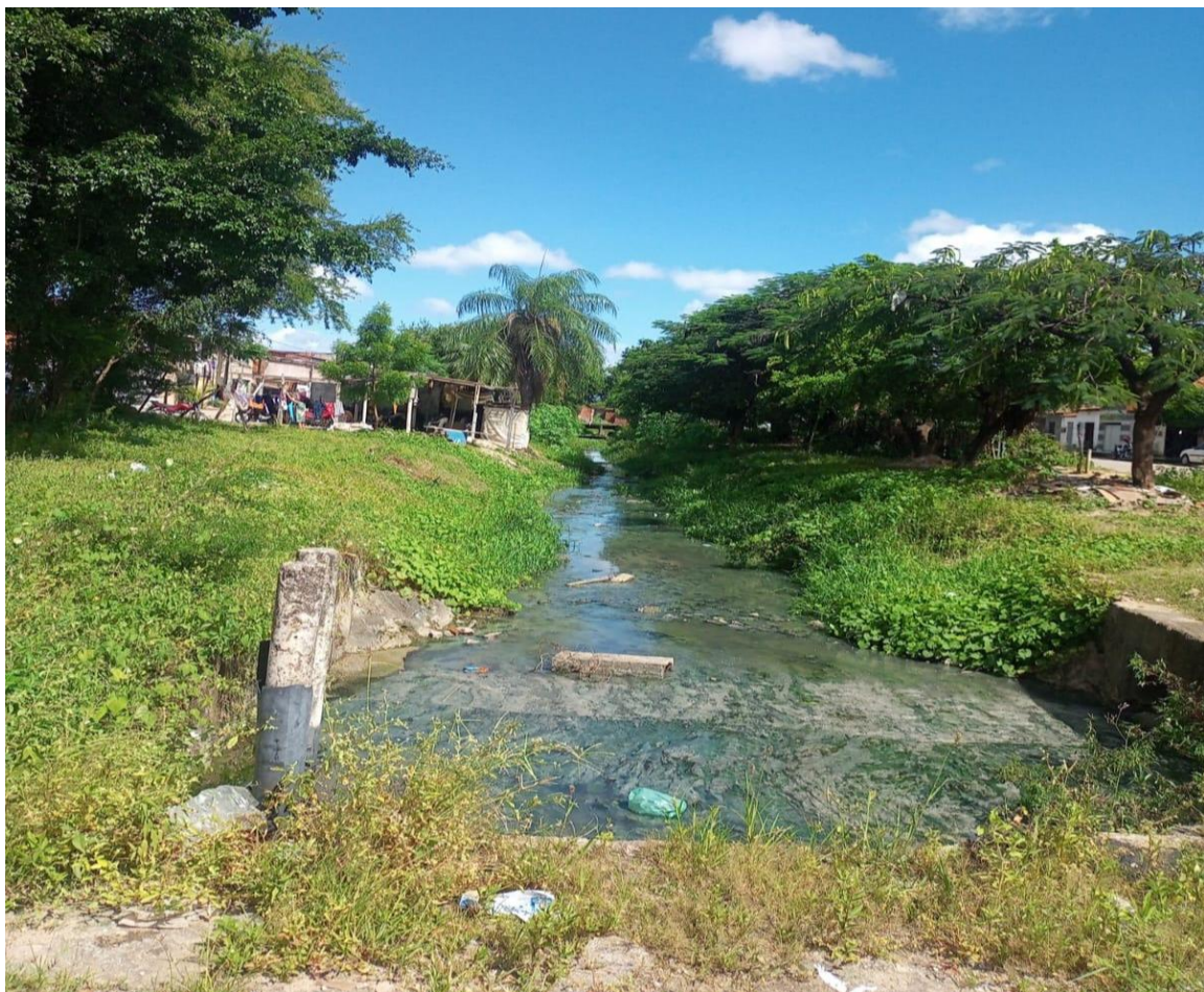
Figura 1 – Comunidade São Francisco às margens do córrego do Rio Maranguapinho, Rua Umuarama, Granja Lisboa, Fortaleza-CE.
