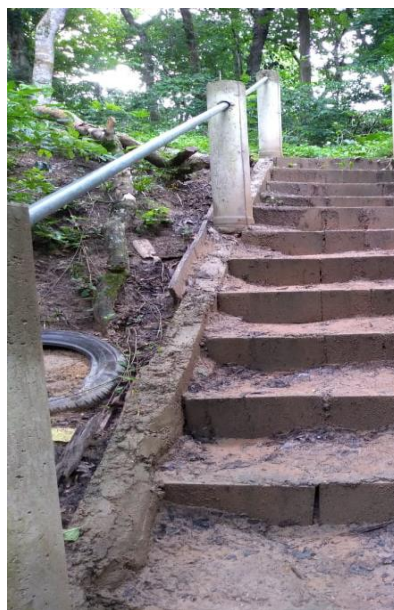
Figura 14 – Estruturas na APP
