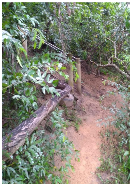
Figura 13 – Estruturas na APP
