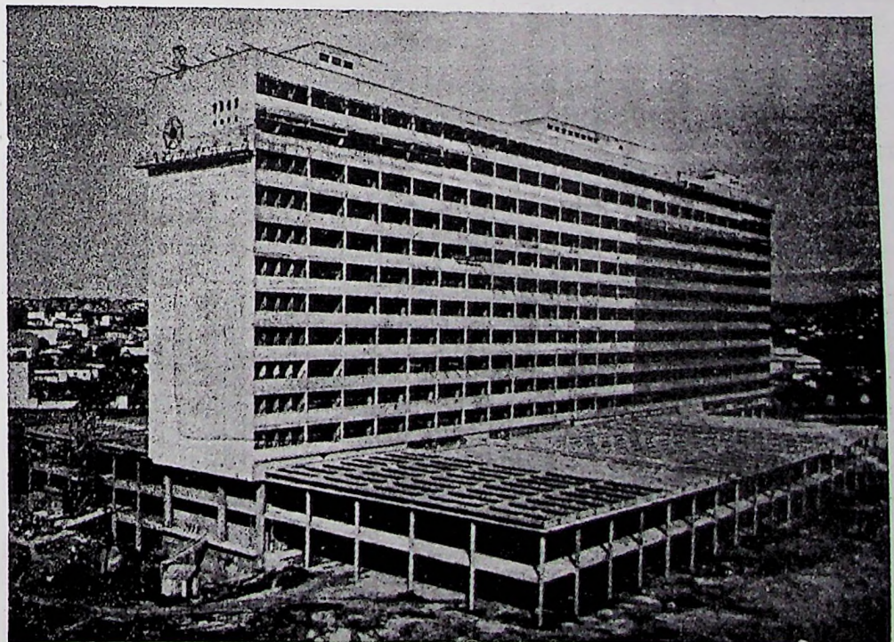
Hospital de Clínicas, o maior e principal dos quatro blocos hospitalares que constituem o Centro Médico da U. R. G. S.
