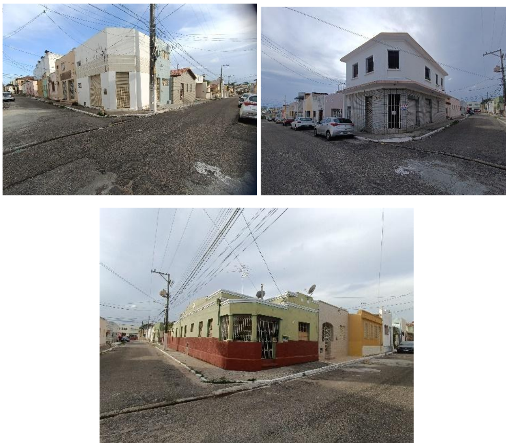
Figuras 4, 5 e 6: Encruzilhadas da Cidade Alta e o trilho do bonde que corta parte do bairro. Fotos de Júlia Motta
