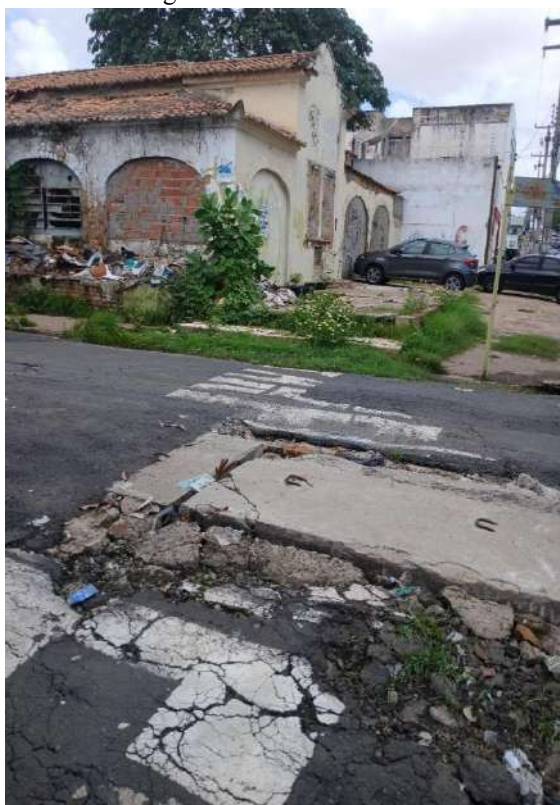
Figura 9: Prédio em deterioração e rua danificada na região central de Teresina-PI
