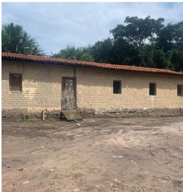
Fotografia 5: Casa de adobe coberto com telha cerâmica
