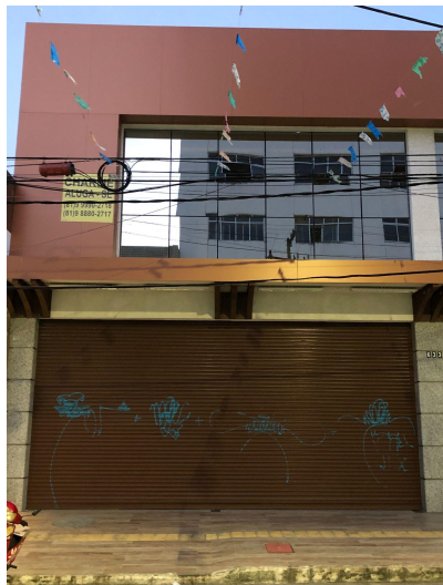
Figuras 5 e 6: Prédio localizado na Rua Princesa Isabel e o segundo, antiga loja C&A na Av. Rio Branco
