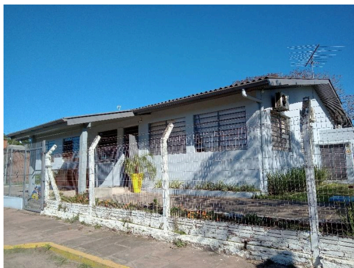
Figura 16: Antigo prédio da E. M. E. F. Santo Antônio – agora Casa Abrigo Fonte: acervo da pesquisadora, 2022.
