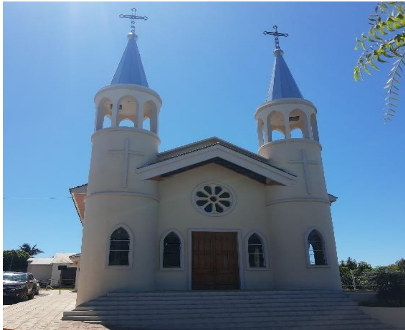
Figura 4 – Nova igreja Nossa Senhora dos Remédios em Quevedos/RS
