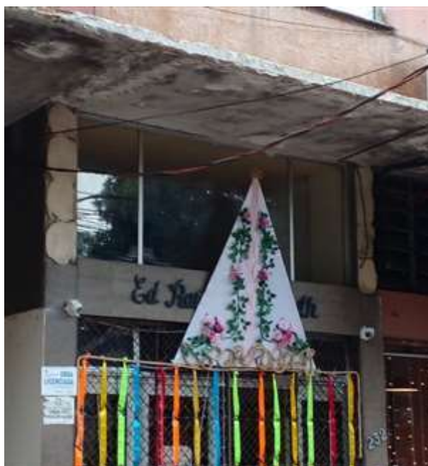
Figura 18 – Triângulo na fachada de prédio, fitas coloridas.
