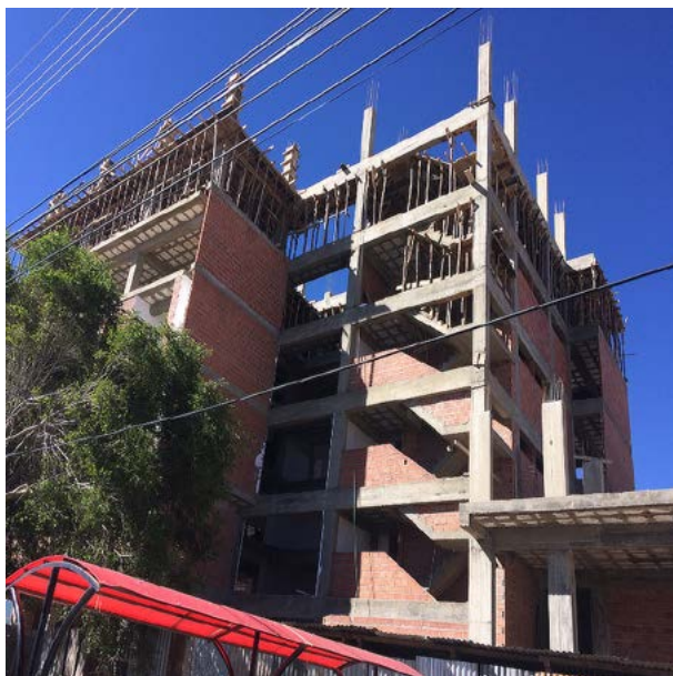
Figura 8. Construcción de galería comercial vertical en el centro de Uyuni. Buena parte de la renovación arquitectónica de la ciudad está siendo realizada a través de inmuebles orientados a ampliar el espacio comercial disponible, debido, entre otros fenómenos, al intenso público que articula el etnoturismo en la EFAL. Fuente propia (2018).
