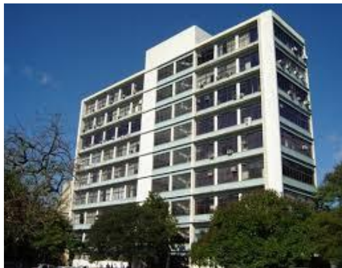
Figura 2 – O Prédio Azul da FAGED/UFRGS (Superior) e o mapa de localização do campus Centro da UFRGS (prédio 1, na imagem inferior)
