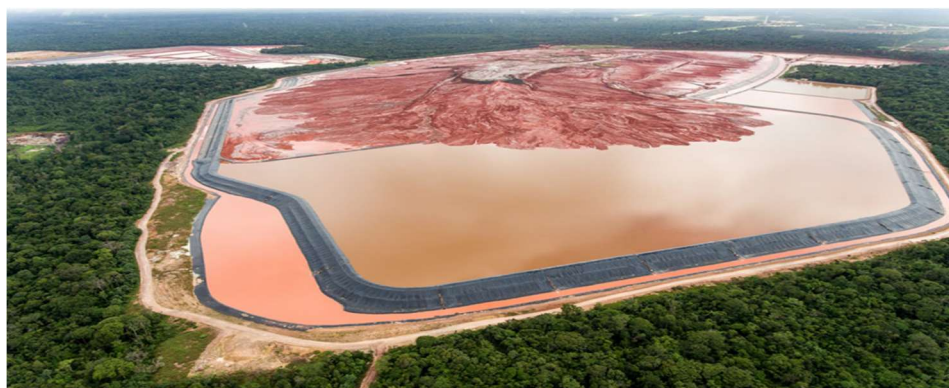
Foto3: Vazamento da bacia de resíduos sólidos DRS1 da Hydro-Alunorte, em Barcarena-Pa.
