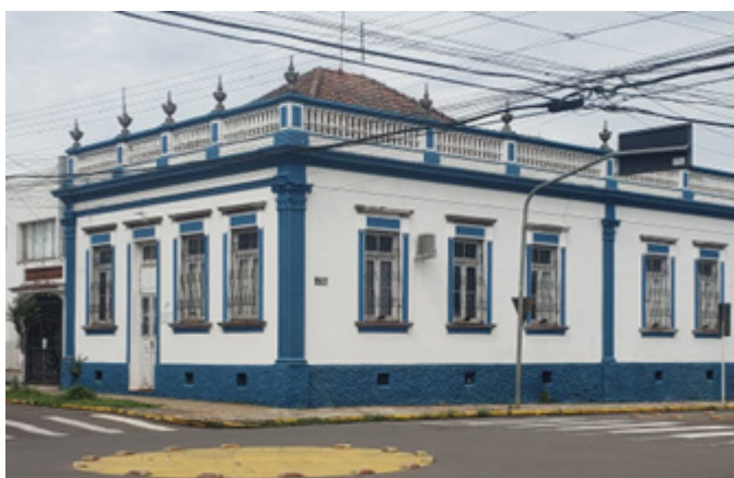
Figura 1- Palacinho onde é a sede do Grupo Máschara, Localizada na Cidade de Cruz Alta- RS
