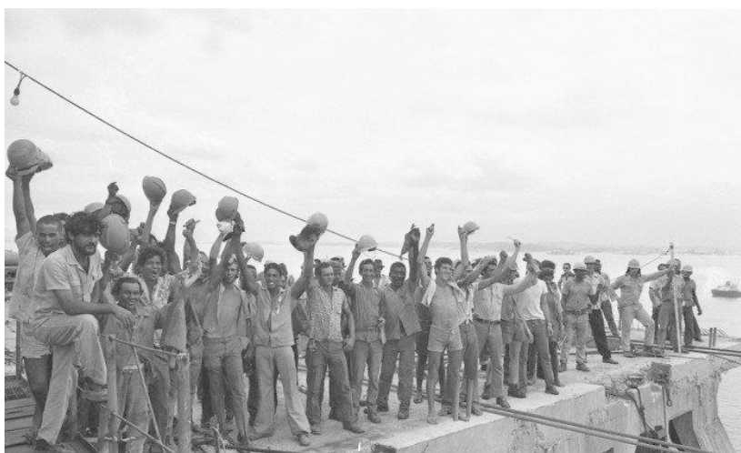
Figura 1 – Trabalhadores na obra de construção da Ponte Presidente Costa e Silva
