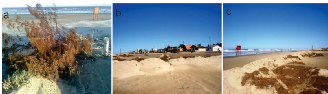
Figura 6: Incremento das armadilhas de contenção dos sedimentos utilizando galhos de casuarina oriundo das podas do balneário. Ano de 2006. Fotos: Autores.
