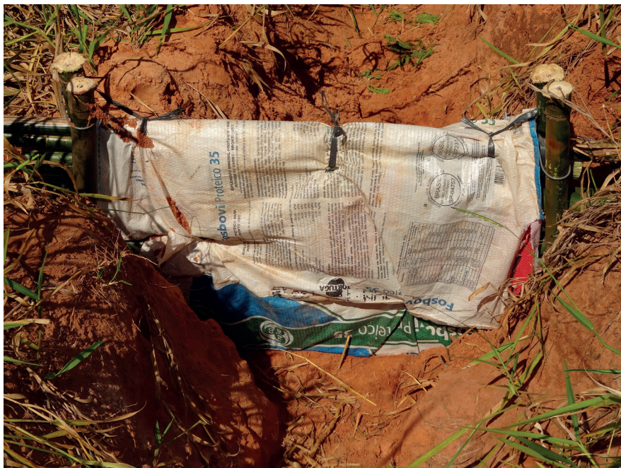
Figura 04 - Barreira com bambus impermeabilizados por ráfia.
