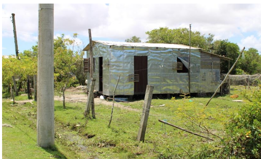
Figura 3 – Residência de madeira forrada com lata.
