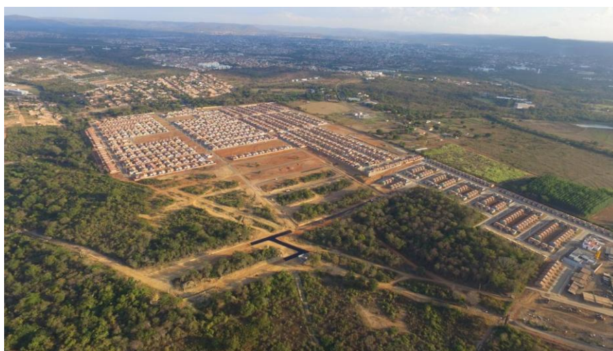
Figura 5- Conjuntos habitacionais contíguos, área norte de Montes Claros-MG. Fonte: BARBOSA, R.S. (2016)
