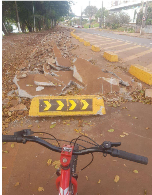
Figura 08: Ciclovía interditada na rua Bento Munhoz da Rocha Neto Fonte: O autor, 2020.
