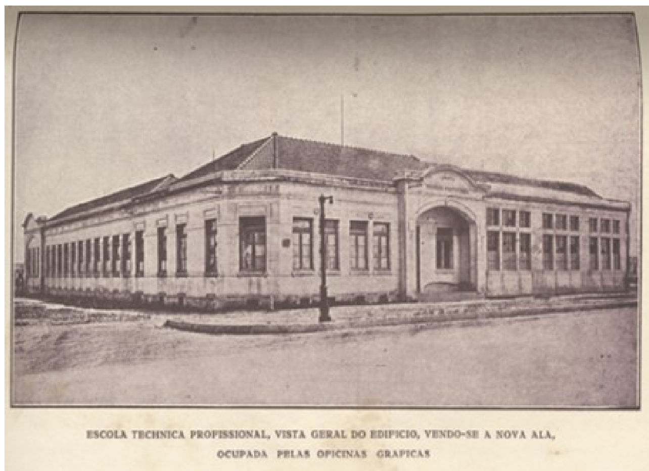
Figura 5 – Edifício da Escola Técnico-Profissional após a construção da nova ala.
