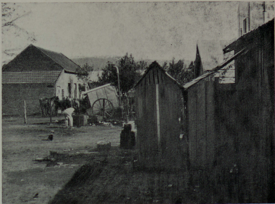
FIG. 8 — Avenida Rio Branco. Fundos das casas da fotografia anterior (n.º 7) em 1924.
