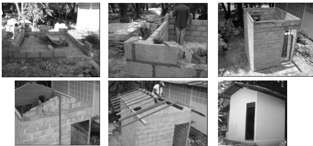
Figura 2 - Execução do protótipo com uso dos blocos EVA na área externa do LABEME/CT/UFPB
