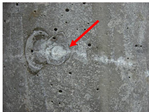
Figura 11 - Aparecimento de eflorescência
