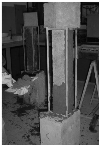
Figura 4 - Pilar sendo reforçado
