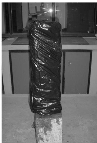
Figura 6 - Cura dos pilares reforçados
