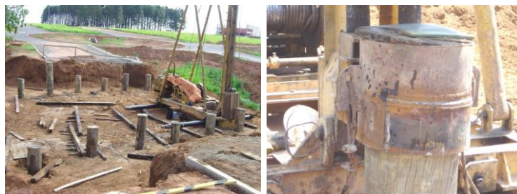
Figura 2 – Bate-estacas com martelo e capacete
