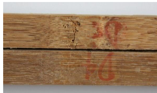
(b) Após a abertura da viga
