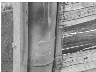
Figura 7 - Fixação e revestimento dos painéis
