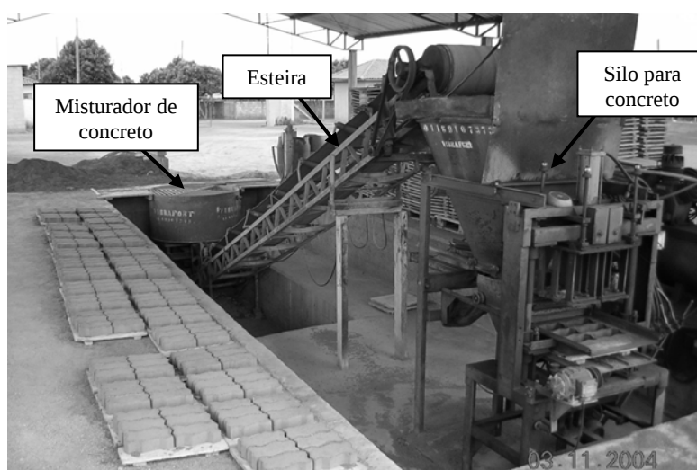
Figura 3 – Moldagem dos blocos de concreto na vibro-prensa semi-automática
