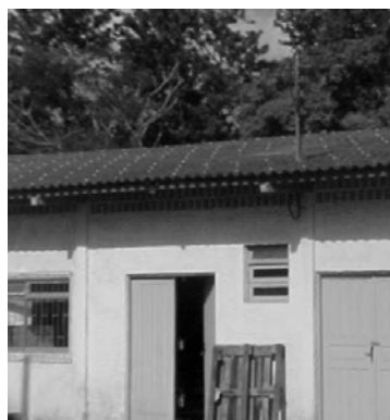
Figura 2 - Barracão de alvenaria - fachada
