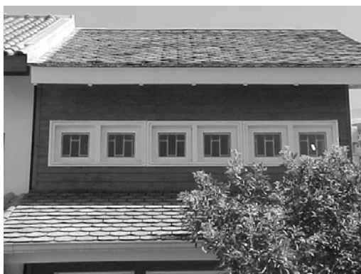
Figura 1 - Protótipo de madeira - fachada
