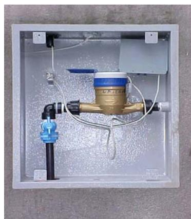
Figura 1 - Instalação da caixa de proteção do hidrômetro e da interface remota
