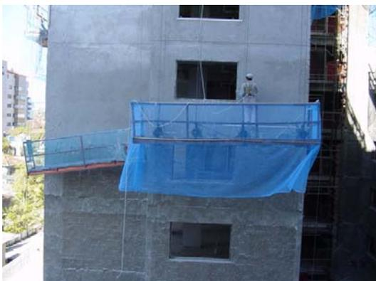
Figura 3 - Vista frontal de um andaime leve (à esquerda) e de um pesado (à direita)
