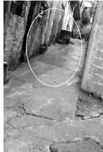
Figura 6 - Reservatório domiciliar (caixa d’água): interferência sobre viário na Favela Parque Amélia, Município de São Paulo
