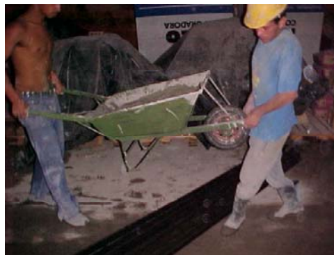
Figura 9 - Estoque de trilhos interrompendo o fluxo de trabalho da obra
