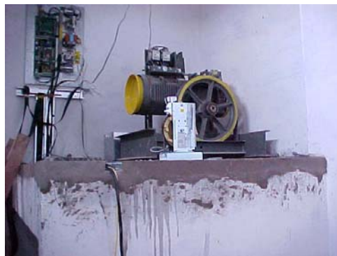
Figura 3 - Retrabalho na laje da casa de máquinas
